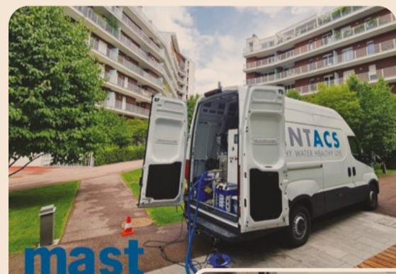
Unità Mobile Temporanea collegata ad un impianto idrico per la bonifica
