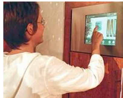
L'impostazione della centralina di un impianto domotico
