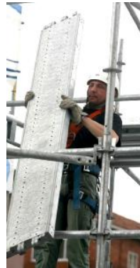
Addetto in un cantiere edile
