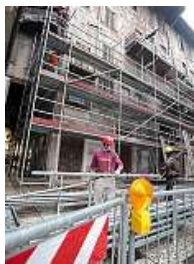
Un cantiere in sicurezza
