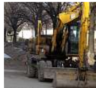
Un cantiere stradale
