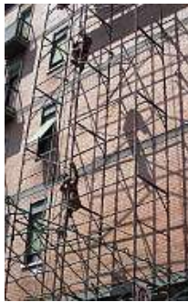
Operai al lavoro in un cantiere
