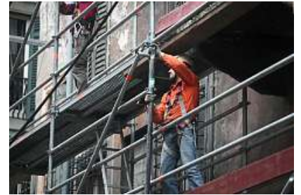
Addetti al lavoro in un'impalcatura
